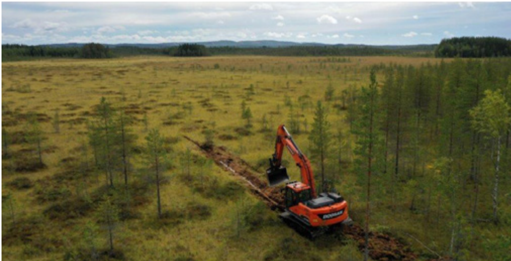
Pienelläkin toimenpiteellä pystytään joskus parantamaan suon luonnontilaa. Kuvassa avosuon reunalla olevalta yksittäiseltä ojalta on vedet johdettu padon ja viisteejan avulla keskeemmälle suota, vesien luontaiseen kulkusuuntaan. Kuva: Anna-Riikka Ihantola
